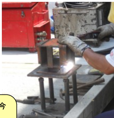
ジャッキ架台
