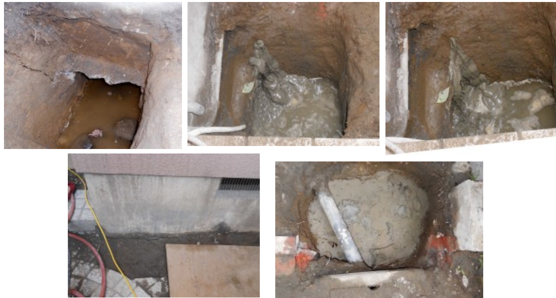
ダブルロック打設・土壌改良状況
