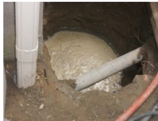
ダブルロック打設状況
